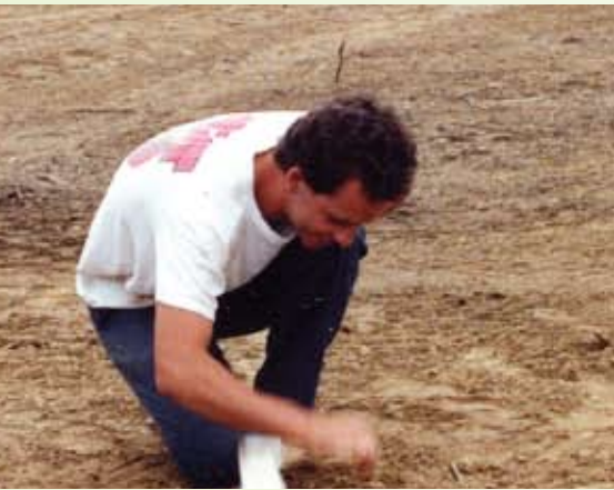
Claude en train de mesurer lors de la construction du deuxième parcours Le Canton.
